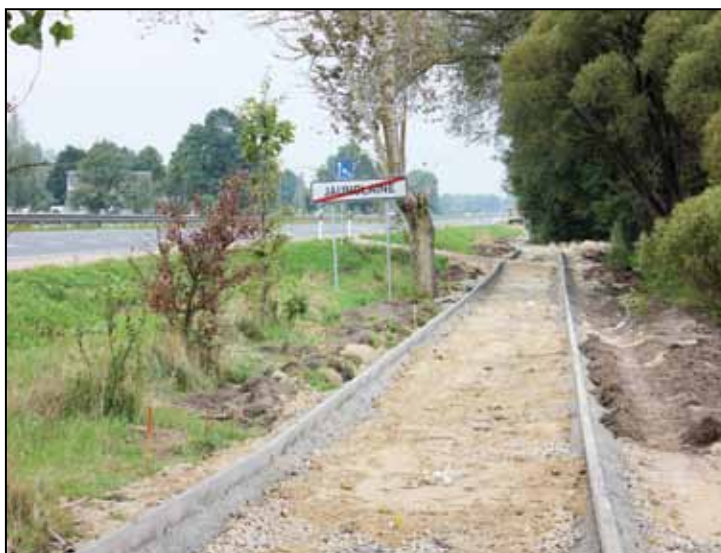
Turpinās gājēju – velosipēdistu celiņa Jaunolaine – Olaine būvniecības darbi
