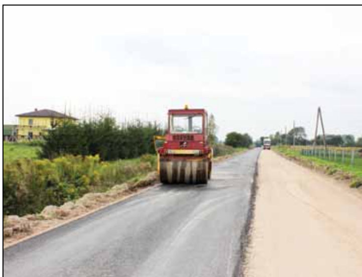
Tiek ieklāts asfalta klājums ceļam CA006 Rubeņi – Lībieši (gar mehāniskām darbnīcām)
